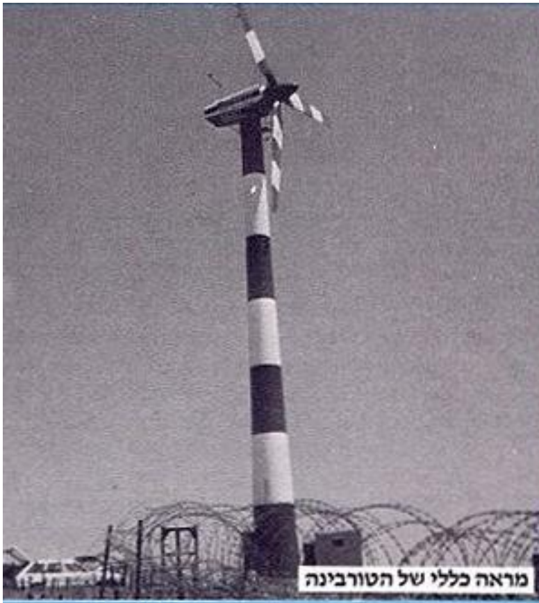
טורבינת רוח – הר בני צפת (1985) יצרן - ווסטאס הספק נקוב - 55 קו"ט מגדל – 22 מ' קוטר רוטור – 15 מ' תפוקה שנתית ממוצעת: 135 Gwh
