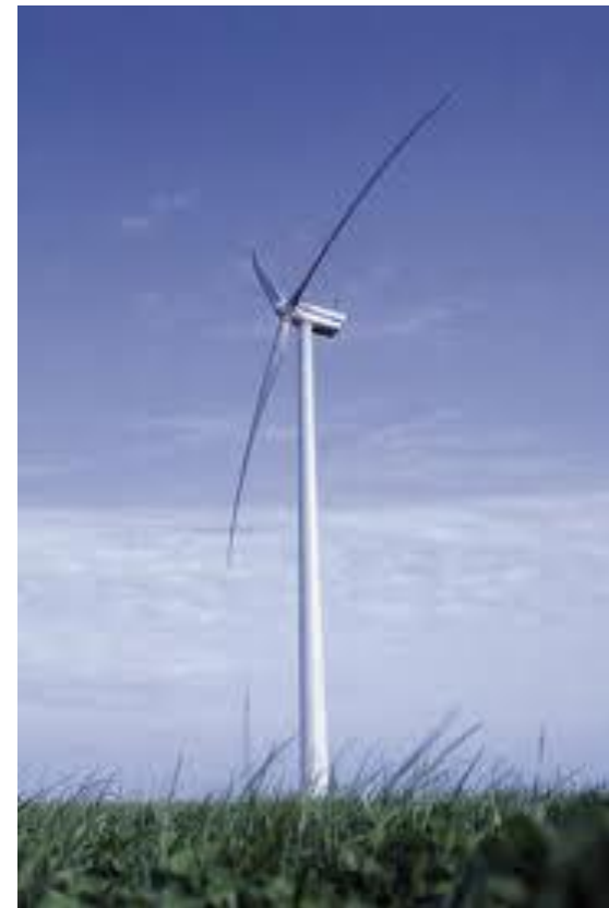
טורבינת רוח מתוכננת (20??) יצרן: נורדקס הספק נקוב: 2500 קו"ט קוטר רוטור: 80 מ' מגדל: 80 מ' תפוקה שנתית מחושבת: 6500 Gwh
