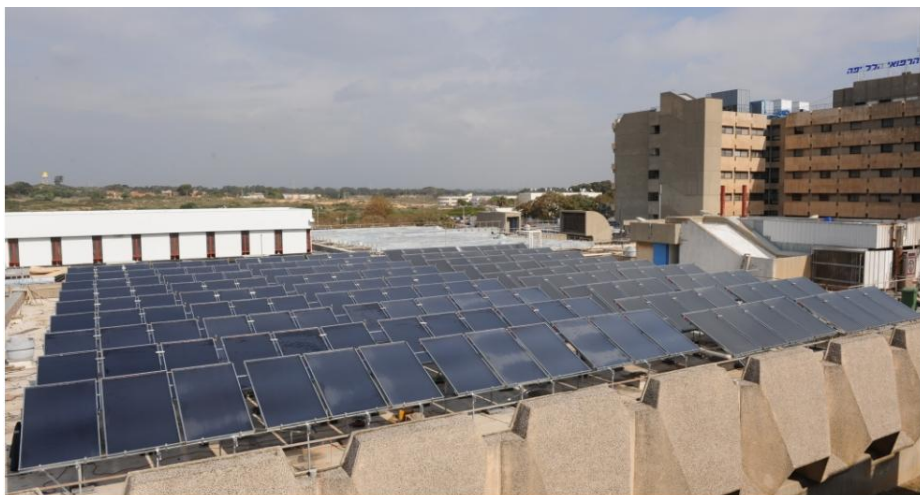
איור 11 - מערכת סולארית של כרומגן בבית חולים "הלל יפה" בחדרה לאספקת 35\text{m}^3 מים בטמפ' 60^\circ\text{C}
